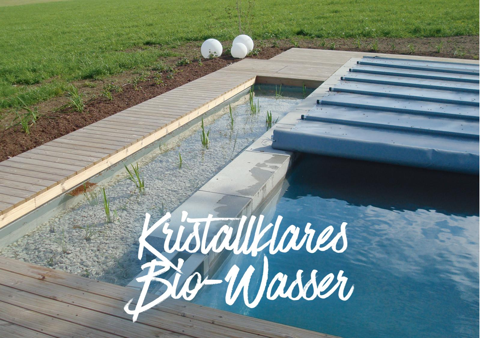
Die downflow Zonen-Einheit ist ein einfaches, modulares Verteilsystem mit integrierter Reinigung (Luftspülung) zur schnellen und sicheren Errichtung von geschütteten Kies-/Zeolith-Filtern in BioWaterPools. Im einfachsten Fall wird der Filter direkt an den Schwimbereich angebaut. Mit einer ST Tauchpumpe kann hier unterhalb der downflow Zonen-Einheit
